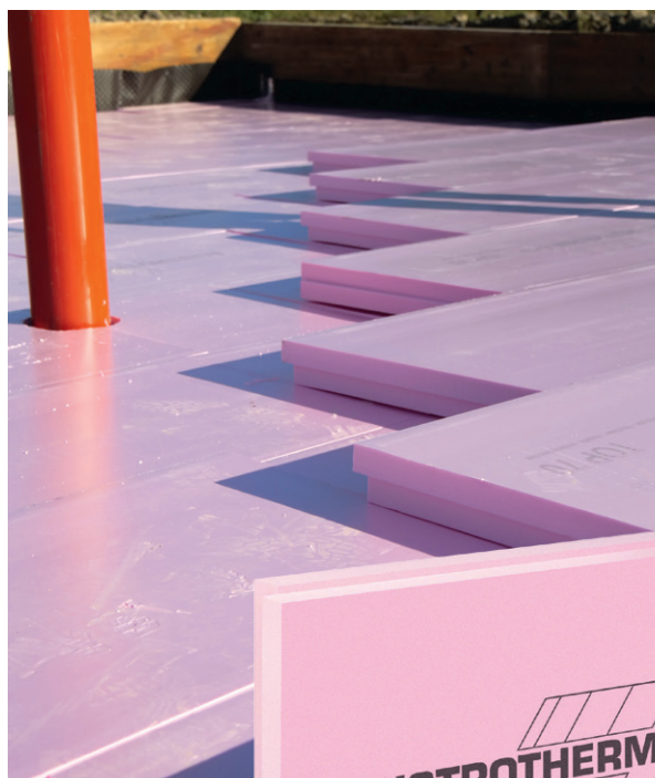
Az ÉMI-mintaházparkban megépült Leier-ház padlójába 16 cm vastag extrudált polisztirol hőszigetelés került a lemezalap alá
