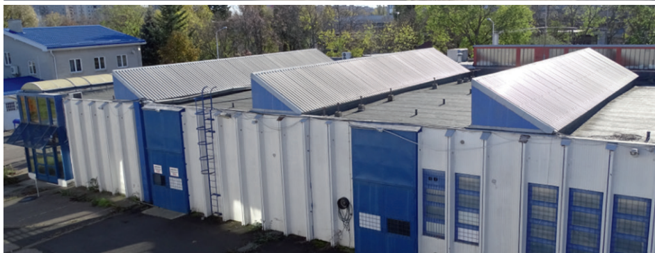
Irodaépületi gázóra a galériázott raktár oldalfalán, a tetőn hűtőgép (fent) és az üzemsarnok-épület – eredeti állapot
