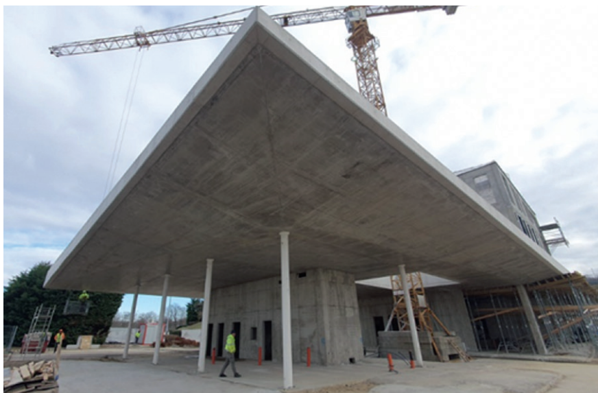
A kizsaluzás után a konzolokról készült helyszíni képek
