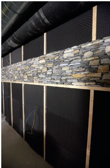
Hangszigetelés kerül még a falburkolat mögé is (forrás: Facebook, Old Constellation), és a pillanat, amikor a mennyezeti borítás meggyullad (forrás: Wikipédia)
