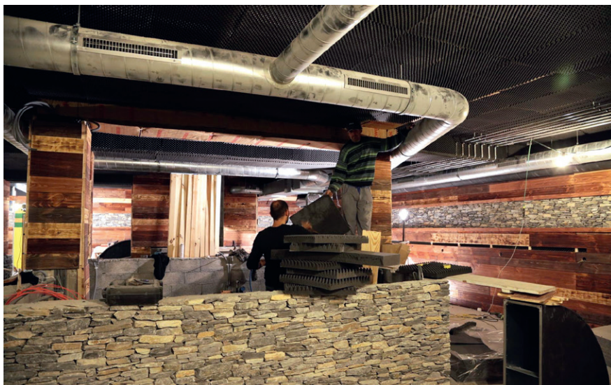
Az átalakítások során a teljes bár mennyezetét éghető hangszigeteléssel látják el. Ennek a típusú hangszigetelésnek egyébként létezik égéskésleltetett változata – ez nem az volt (forrás: Facebook, Old Constellation)
