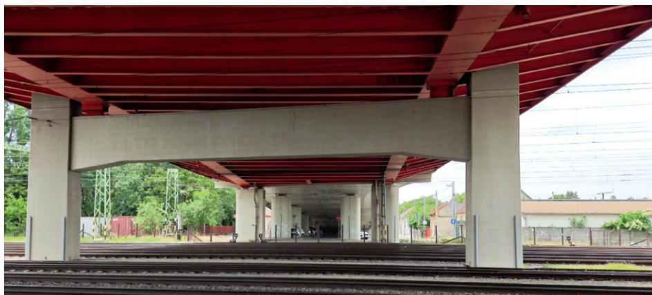
2. ábra: Az északi pilonnál (jobb oldalon) fix, a déli pilonnál (bal oldalon) egy irányban mozgó saru pozíciója a pilonösszekötő gerendán
