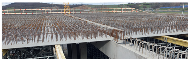
A nyírási csapokat tartalmazó előregyártott zsalupanelek elhelyezése után
