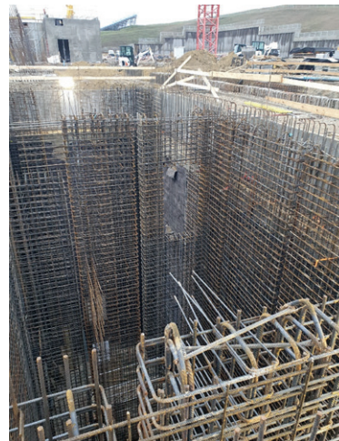
Főlelátó-épület – előszerelt bélésfal-armatúrák
