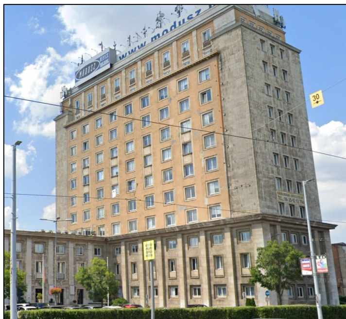
11. ábra: Módusz irodaház, Budapest VIII. Könyves K. krt. 76. (1953.) Süttöi traventin, édesvízi mészkő lap burkolathagyományos huzalkapcsos rögzítéssel
