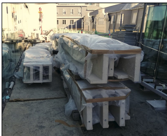
30. ábra: Kivitelezés közben állványra, illetve födémre terhelt nagyméretű homlokzati elemek
