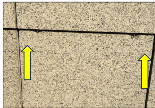
25. ábra: Burkoló kőlap károsodásai rögzítő tüskénél. Mivel mind a két felső tüskénél a kő kitört, így kőlap kiborulás ellen már nincsen biztosítva
