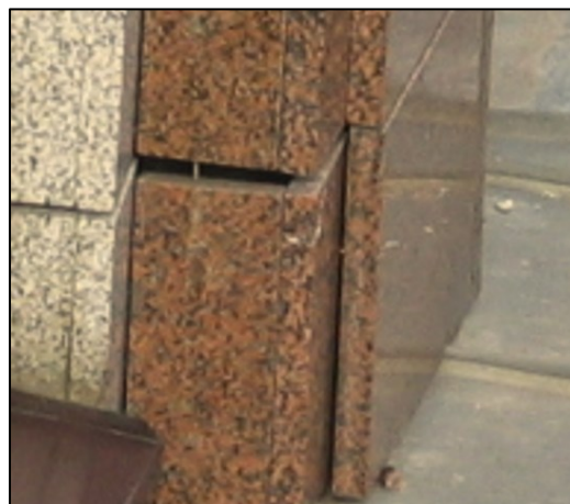
26. ábra: Rögzítési hiányosság és jelentős elmozdulás az induló kőnél
