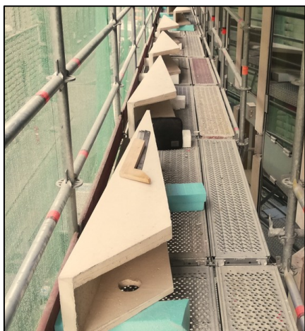
30. ábra: Kivitelezés közben állványra, illetve födémre terhelt nagyméretű homlokzati elemek
