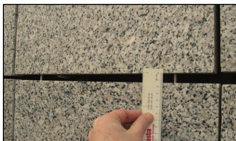
28. ábra: Változó fugaszélesség
