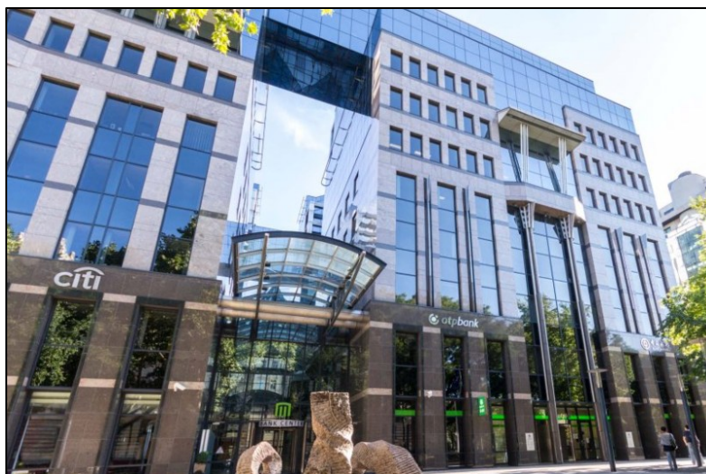
13. ábra: Gránit burkolat, korszerű kőörgzítéssel. Bank Center irodaépület, Budapest, Szabadság tér (1996),
