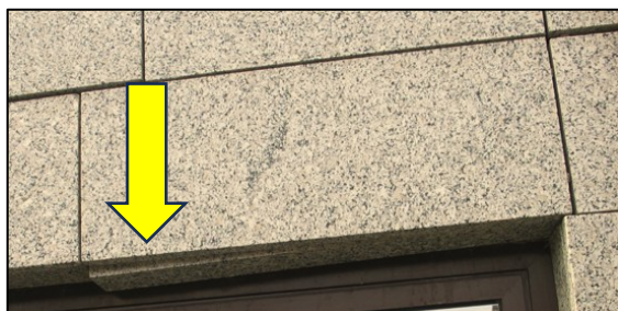
2. ábra: Nem megfelelően rögzített, kimozdult kőlap
