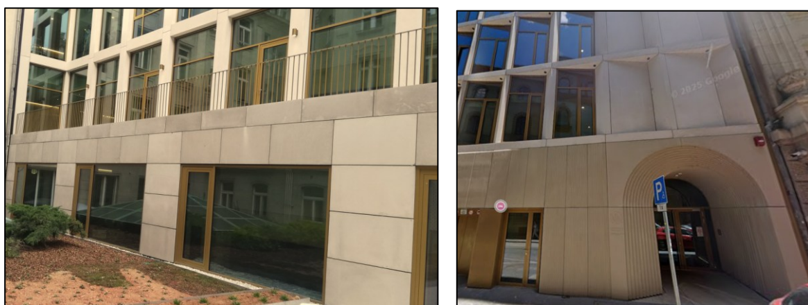
10. ábra: Műkő homlokzatburkolatok - korszerű rögzítő konzolokkal
