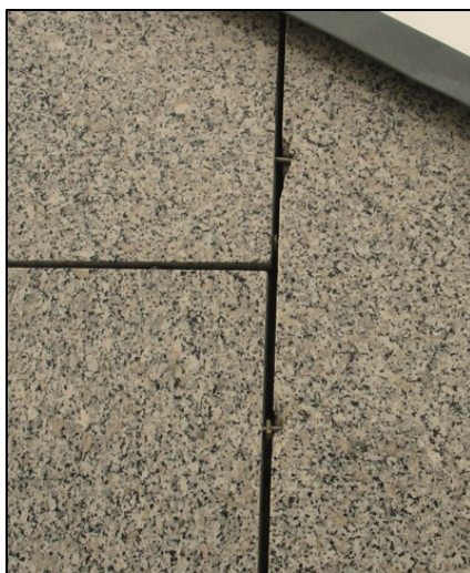
15. ábra: Gránit lap kipattogzásai a rögzítő tűskék környezetében
