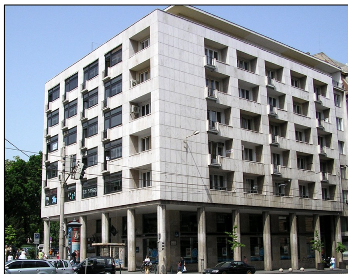
12. ábra: Kőlap burkolat hagyományos huzalkapcsos rögzítéssel, 1959-ből. Budapest, II. ker. Margit krt. 49-51.
