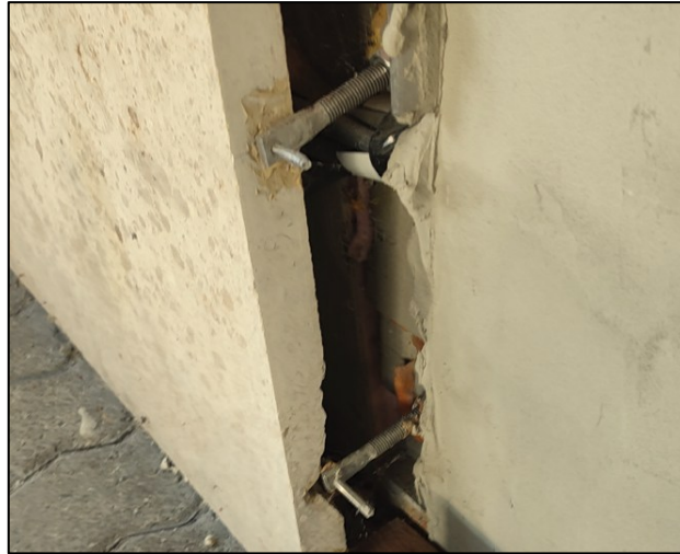
16. ábra: Rögzítő tüskék környezete. A felső tüskénél látszik az utólagos beragasztás, az alsónál pedig a kő kipattogzása
