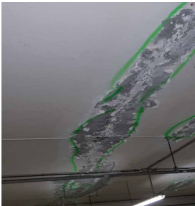
10. ábra: Korrózió nyomai egy hazai parkolófödemen
