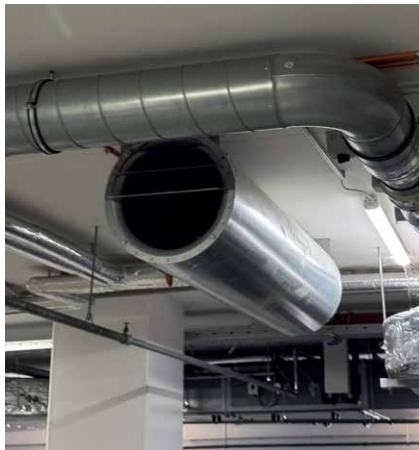
Füstterelő JET ventilátor
