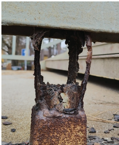
Így is el tud fogyni – tipikus repedéskép a feszítőrozsdra jelenlétéről
