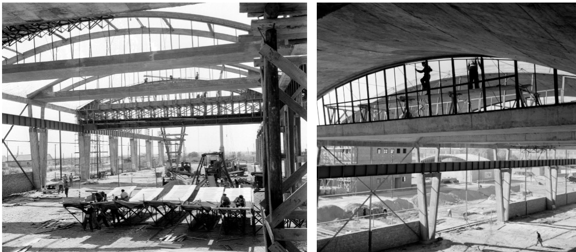
10. ábra: A Székesfehérvári Könnyűfémű alumíniumöntödéje és présműve építés közben [50]
