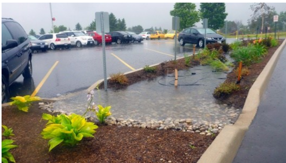
11.kép: biovápa szegélykő megszakításával megoldott bevezetéssel; kőszórással védett bevezetés; IMAX; Mississauga
