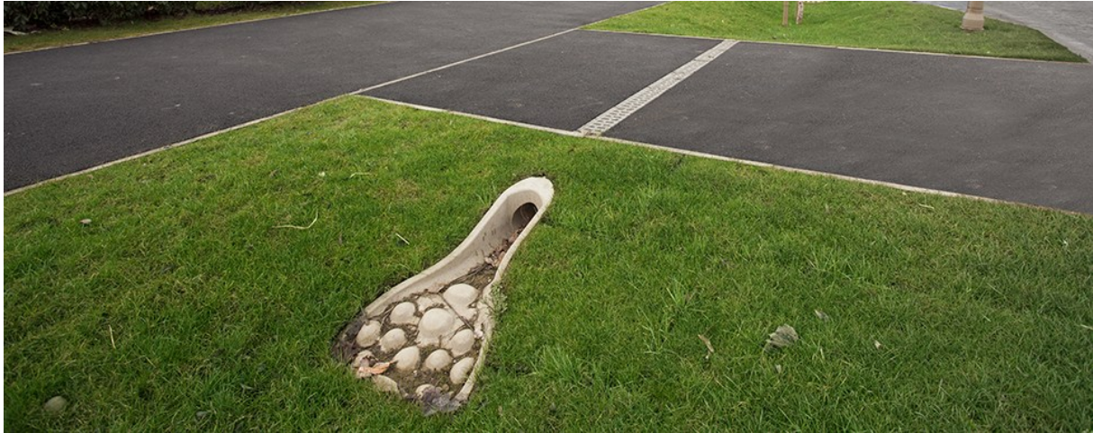
17.kép: surrantós pontszerű bevezetés a biovápa végében erózióvédelmet biztosító, áramlást kiegyenlítő előregyártott ACO elem alkalmazásával ( https://www.aco.co.uk/products/suds-swale-inlet )
