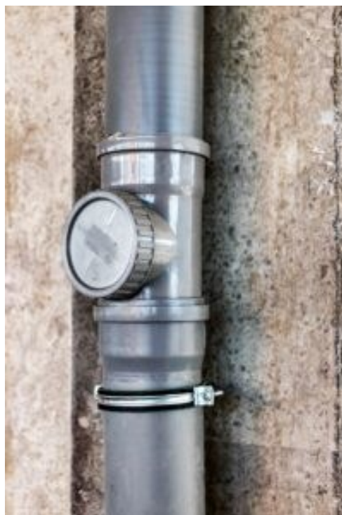
28. kép: tisztítónyílás alkalmazása az esővíz lefolyócsövön
