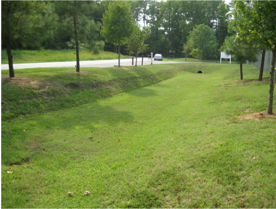
16.kép: füves szűrőszárvval ellátott standard biovápa
