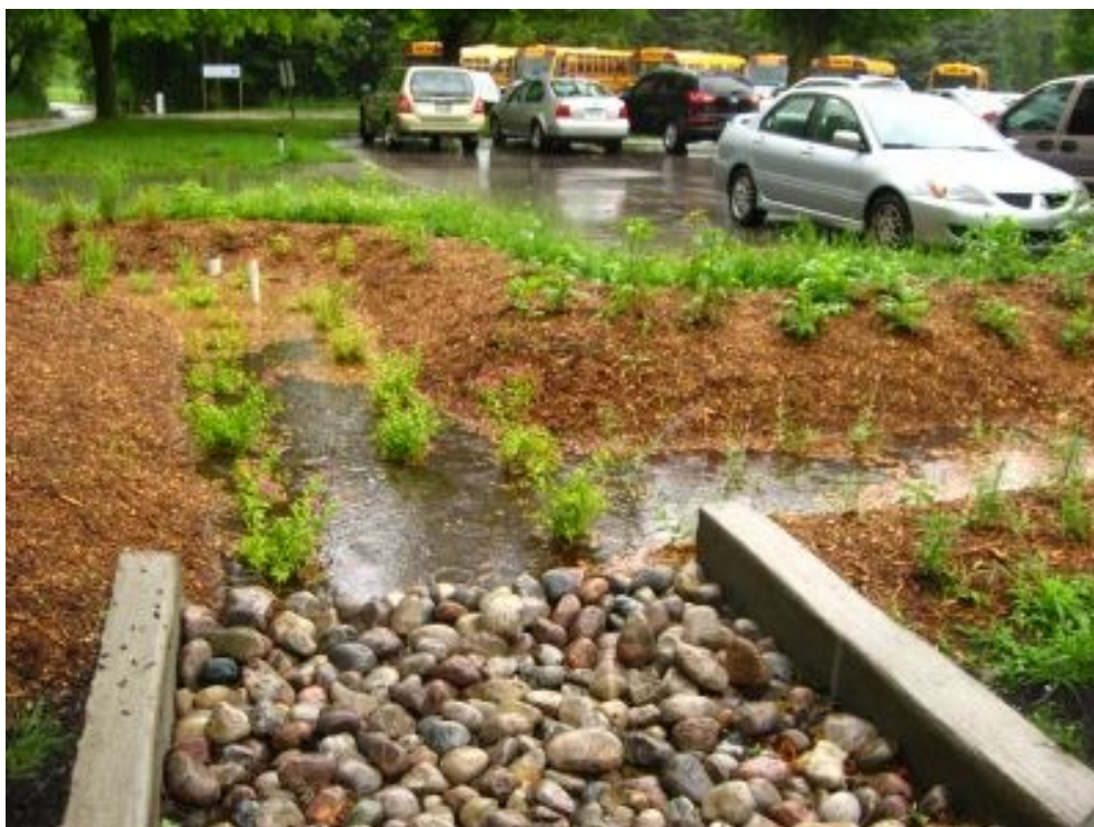
8. kép: vízhozamkiegyenlítést és energiacsökkentést biztosító megoldás
