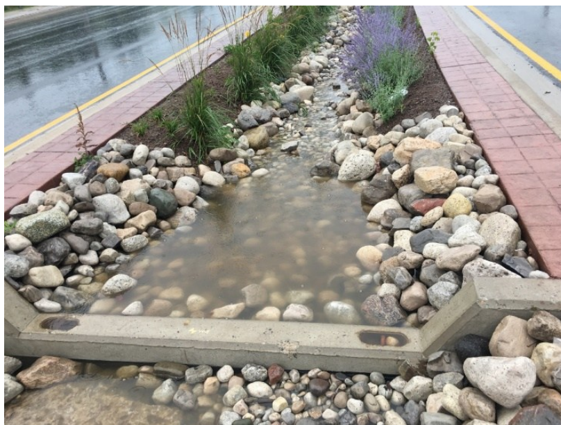
14.kép: keresztgátakkal javított biovápa egyenletes bevezetéssel; Northgate Mall parkoló, Seattle. Photo credit: MLSmith
