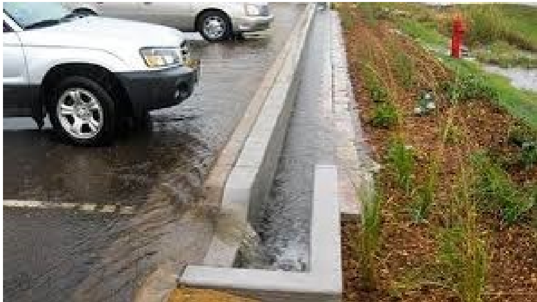
7.kép: vízhozamkiegyenlítést biztosító megoldás
