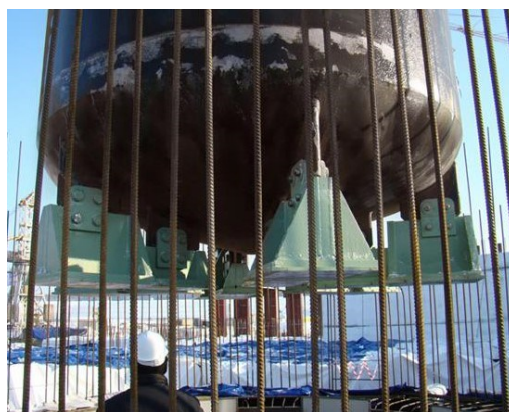
8.2. ábra: Core catcher (olvadék csapda) ([22])
