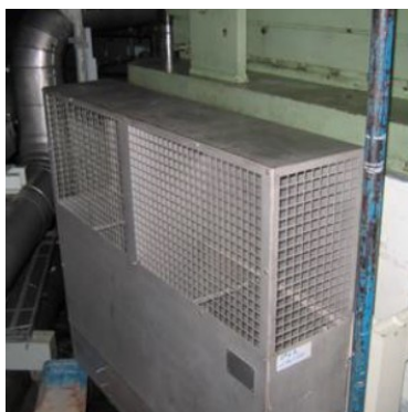
8.1. ábra: Hidrogén rekombinátor (hidrogénégetés) ([22])
