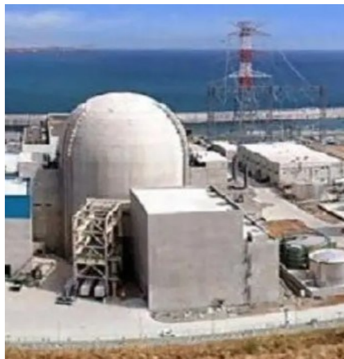
8.8. ábra: Épülő konténment (Egyesült Arab Emírségek)
