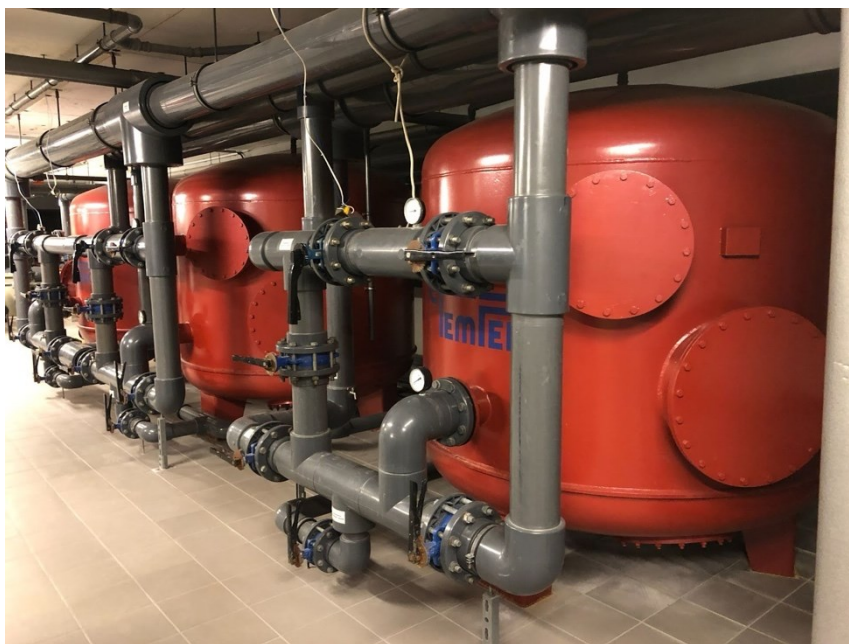
43.sz. ábra Jellemző szelepkiosztás
