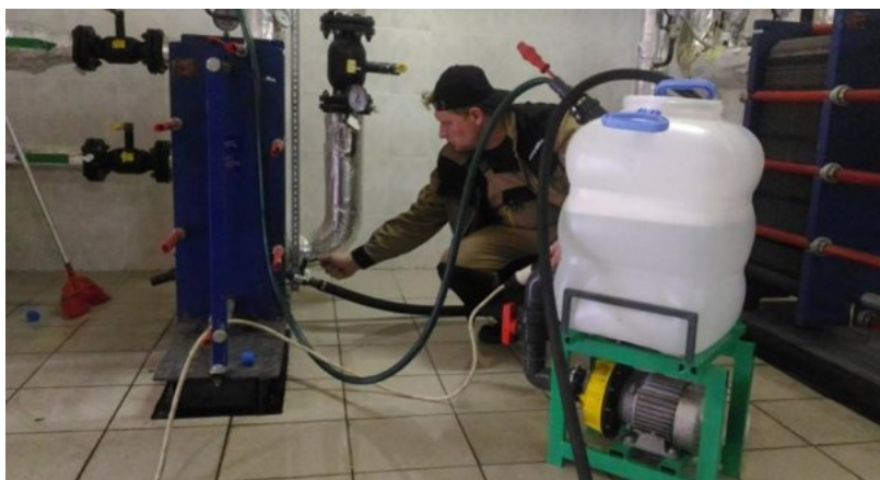
50.sz. ábra Hőcserélő karbantartása
