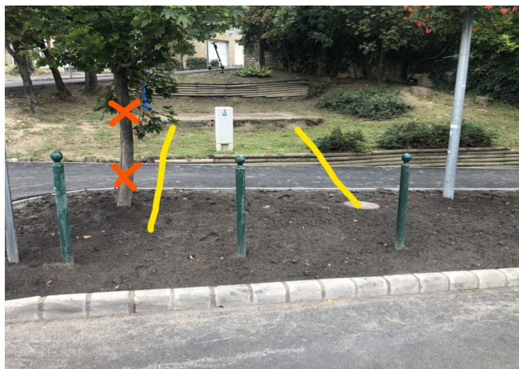
6. ábra Példa az elosztóvezeték biztonsági övezetébe utólag telepített fa esetére.
