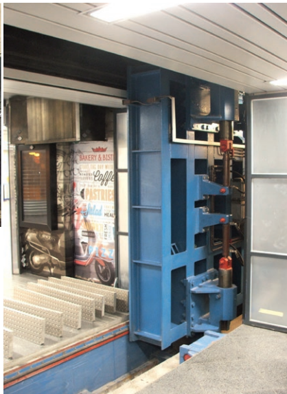
Állomási elzáró (csarnok) kapuzárás közben
