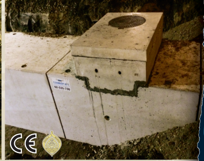
Vasúti aknás kerethíd-keretelem (1)
