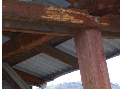
25. ábra Nagy fadarázs és kártétele faszerkezeten
