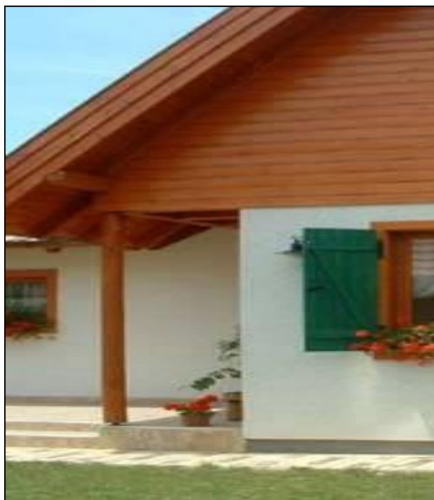
4. ábra. A védőhatás fokozásának eszköze a széles eresz és a vaslábra helyezett tornácoszlop ( www.bedofahaz.hu .)
