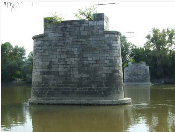
A magyarcsanádi vasúti híd
