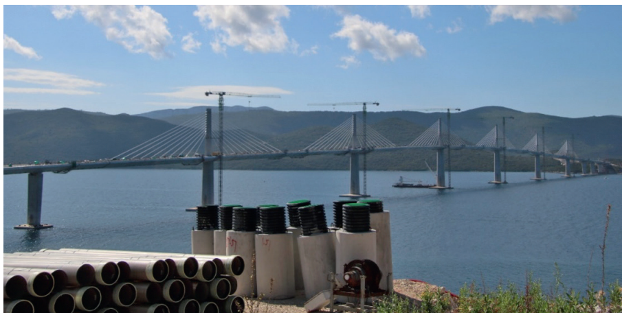
Az építési helyszínt a konténerirodák mellett, a szárazföldi Komarna településnél láthattuk, a híddal együtt
