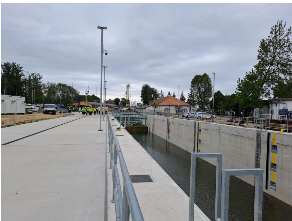
4. Kép: Építési terület hajózsilip
