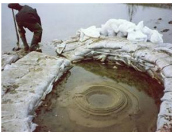
5. sz. képcsoportok: A buzgár kiépített ellennyomó medencéje
