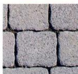
Aprókavicsos fugás köburkolat
