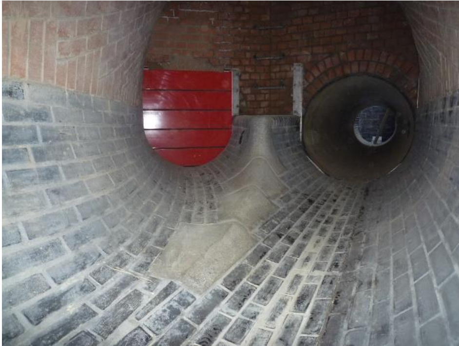
Példa hidraulikailag kedvező kialakítású csatlakozásra
