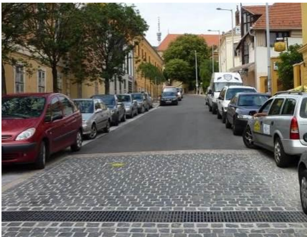
Példa keresztirányú rács beépítésére hegyvidéki területen
