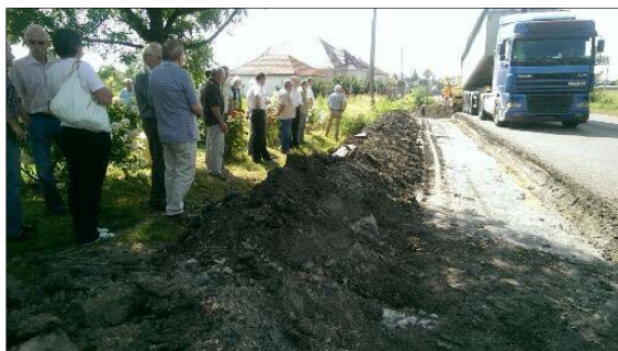
33.sz. főút felújítás-Poroszló
