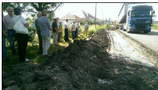
33.sz. főút felújítás-Poroszló
