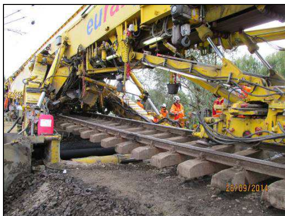
Munkában az alépítményjavító géplánc
