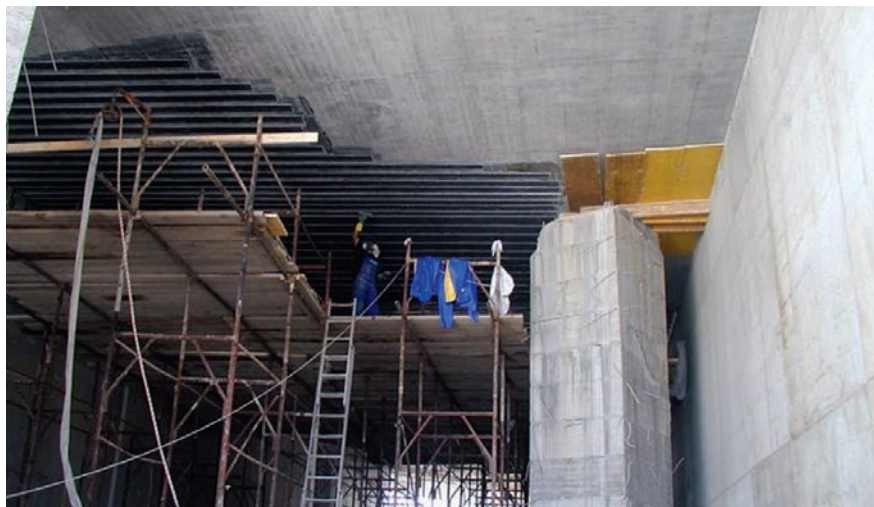
Vasúti aluljáró megerősítése Carboplate-tel – Verona, Olaszország
