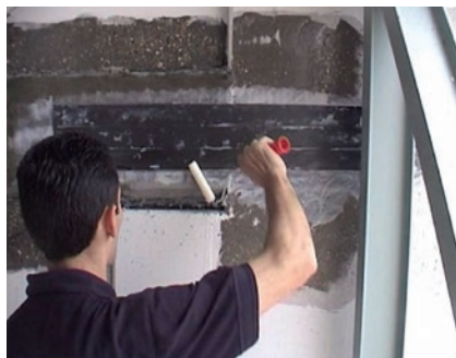
Stadionlelátó megerősítése Carboplate lamellákkal – Nyíregyháza, Stadion
